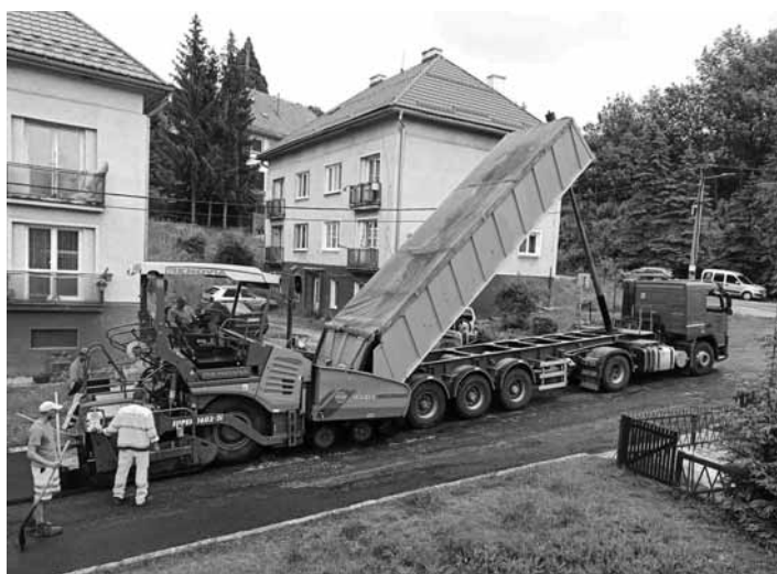
Rekonštrukcia Ul. P. Jilemnického FOTO RADOŠLAV KLEIN
