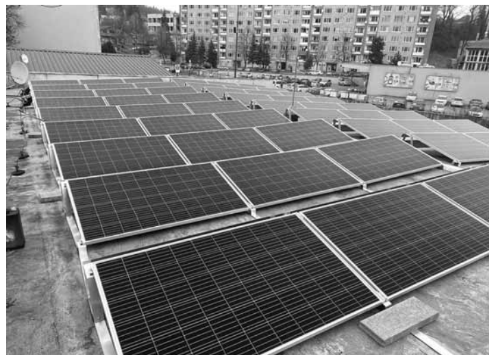
Fotovoltaické panely na kotolni K1 FOTO ARCHÍV BS, S.R.O.
