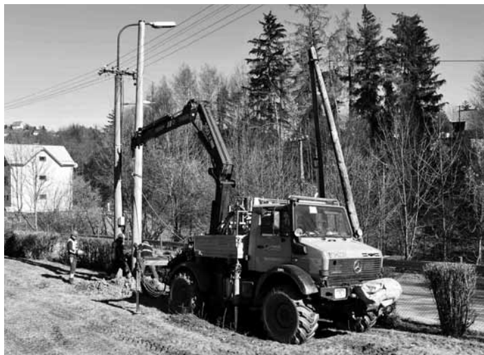
Rekonštrukcia a výmena stĺpov napätia FOTO ARCHÍV SSD, A.S.
