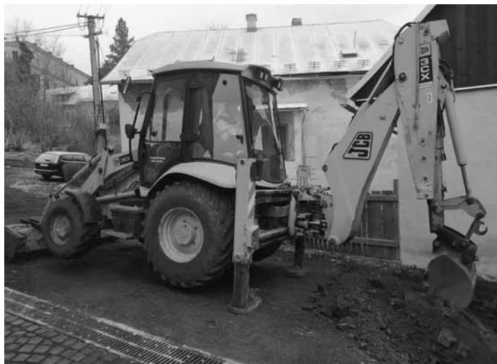
Rekonštrukcia Ul. J. Palárika FOTO MICHAL KRÍŽ
