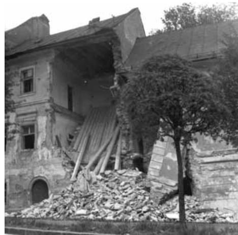
Zrútené fasády a stropy FOTO ARCHÍV SBM
