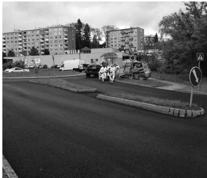
Nový asfaltový povrch na kruhovom objazde FOTO MICHAL KRÍŽ
