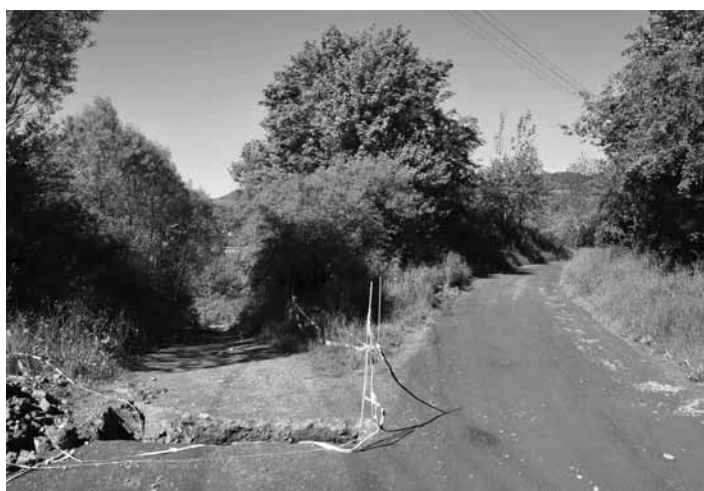
Prípravné stavebné práce FOTO MICHAL KRÍŽ
