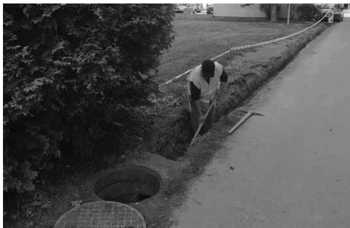
Odvodňovací kanál na Ul. L. Svobodu FOTO MICHAL KRÍŽ
