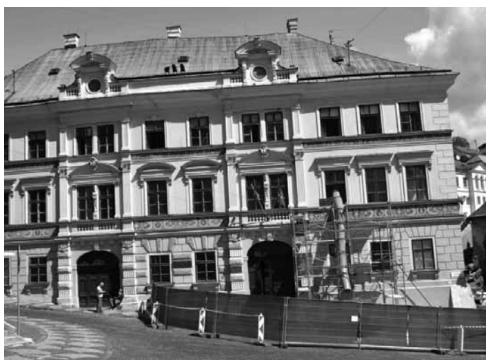
Fritzov dom v rekonštrukcii FOTO MICHAL KRÍŽ
