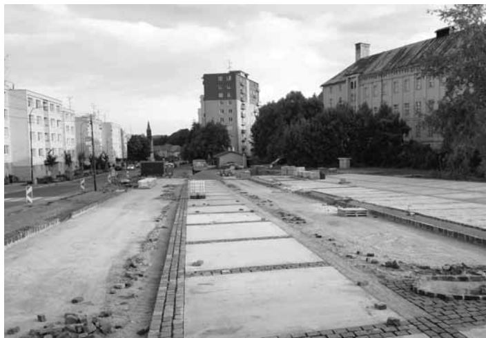
Výstavba parkoviska FOTO PETER KOLEDA
