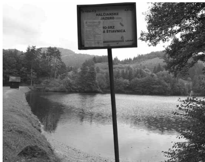
Halčiansky tajch pred rekonštrukciou FOTO MICHAL KRÍŽ
