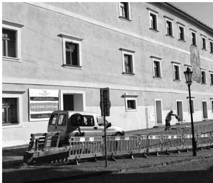
Rekonštrukcia oporného múru FOTO MICHAL KRÍŽ
