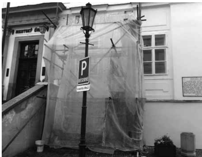
Reštaurátorské práce na fasáde radnice FOTO MIČAL KRÍŽ
