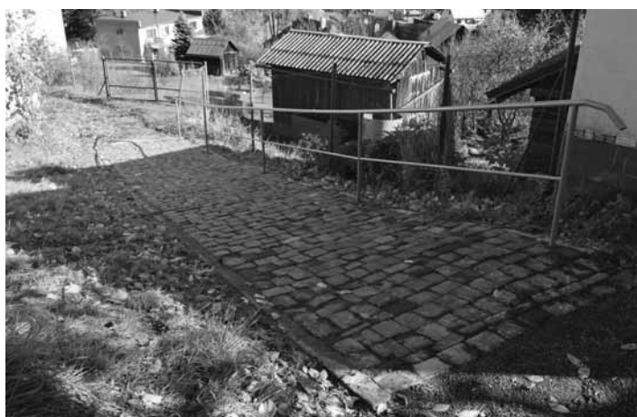
Nová dlažba a zábradlie FOTO MICHAL KRÍŽ
