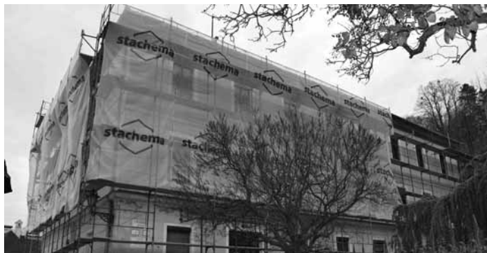
Objekt sociálnych služieb v rekonštrukcii FOTO MICHAL KRÍŽ
