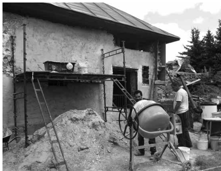
Rekonštrukčné práce v budove bývalej fary FOTO OZ MARTINUS
