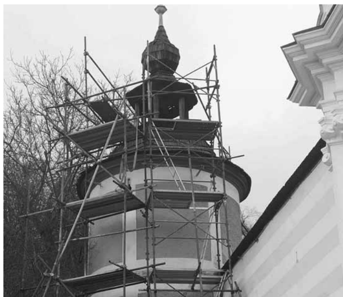
MsÚ Oprava drevenej šindľovej krytiny FOTO ARCHÍV J. CHRENKO
