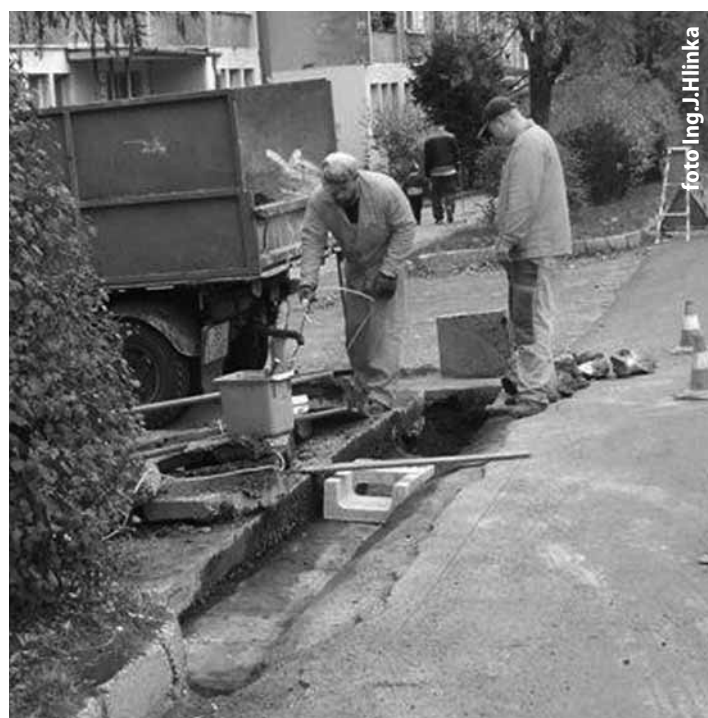
Vybudovanie zachytnej siete na zachytávanie povrchovej vody na MK Ul. Dolná. Práce zabezpečili TS v 45. týždni.
