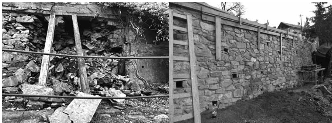
Pred a po rekonštrukcii oporného múru FOTO ARCHÍV J. CHRENKO
