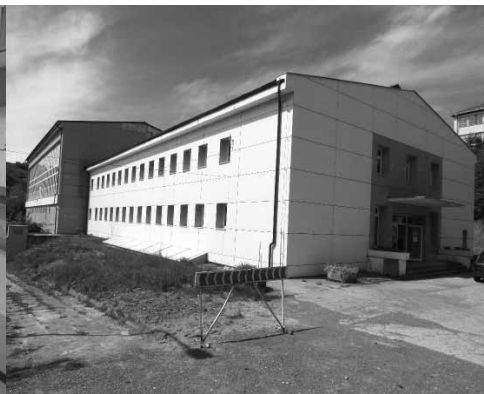
Plaváreň- budova FOTO ARCHÍV MsÚ
