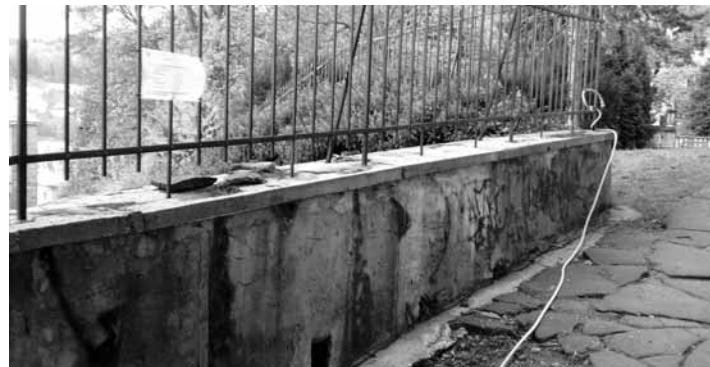
Oprava múru botanickej záhrady FOTO ARCHÍV SOŠL BŠ
