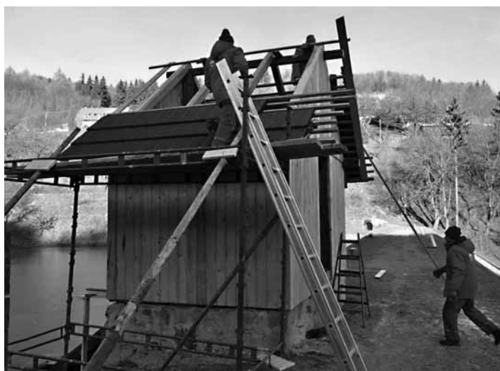
Kladenie šindľov na strechu mnícha FOTO ARCHÍV SVP, Š.P.
