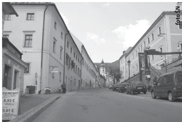
Kammerhofská ulica pred rekonštrukciou.
