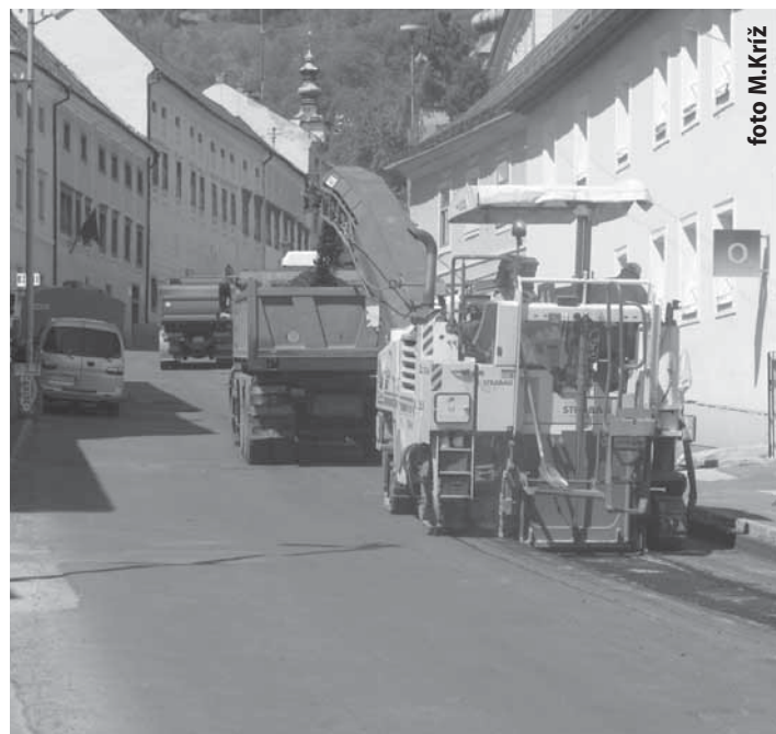
Rekonštrukčné práce na Ulici Kammerhofska by mali trvať až do konca augusta.
