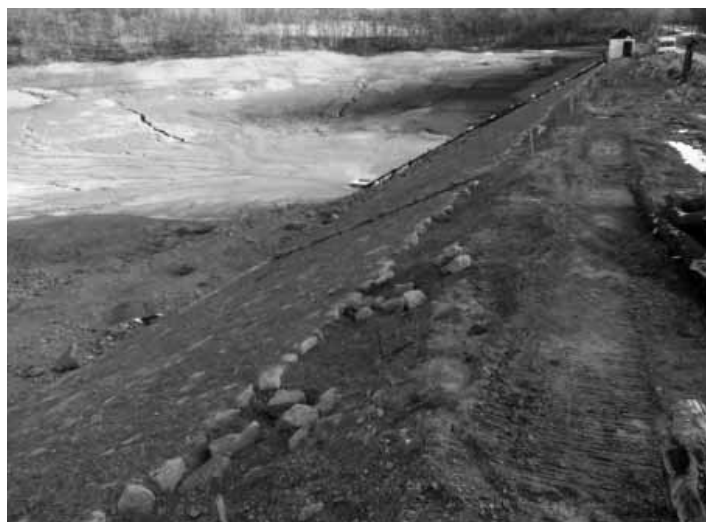
Opevňovanie hrádze lomovým kameňom na Richňave FOTO SVP
