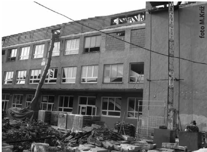
Rekonštrukčné práce na Základnej škole Jozefa Horáka.
