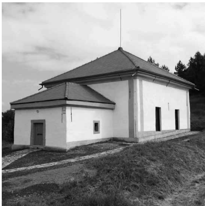
Obnovený objekt Prachárne FOTO ARCHÍV SBM
