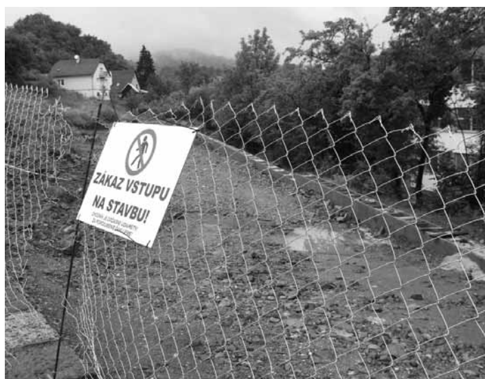
Výstavba "Umyvadieho centra" FOTO MICHAL KRÍŽ
