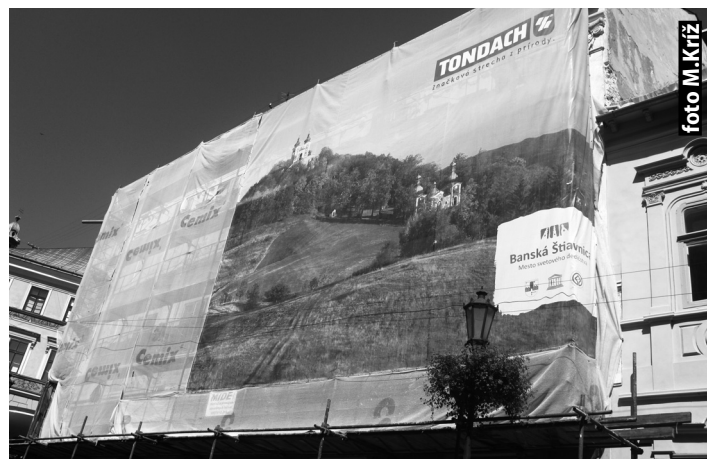
Rekonštrukcia objektu Meštianskeho domu na Ul. A. Kmeťa 5.
