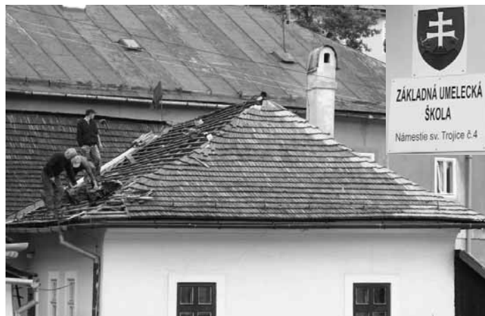
Výmena strešného šindľa na streche ZUŠ FOTO MICHAL KRÍŽ
