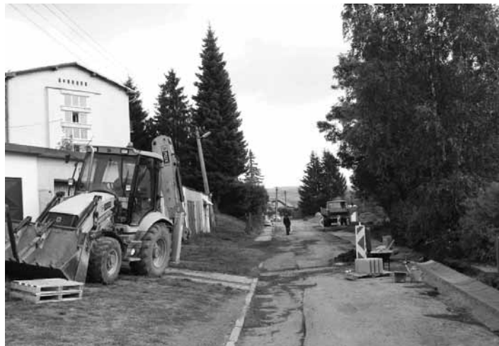
Stavebné práce na Povrazníku FOTO MICHAL KRÍŽ
