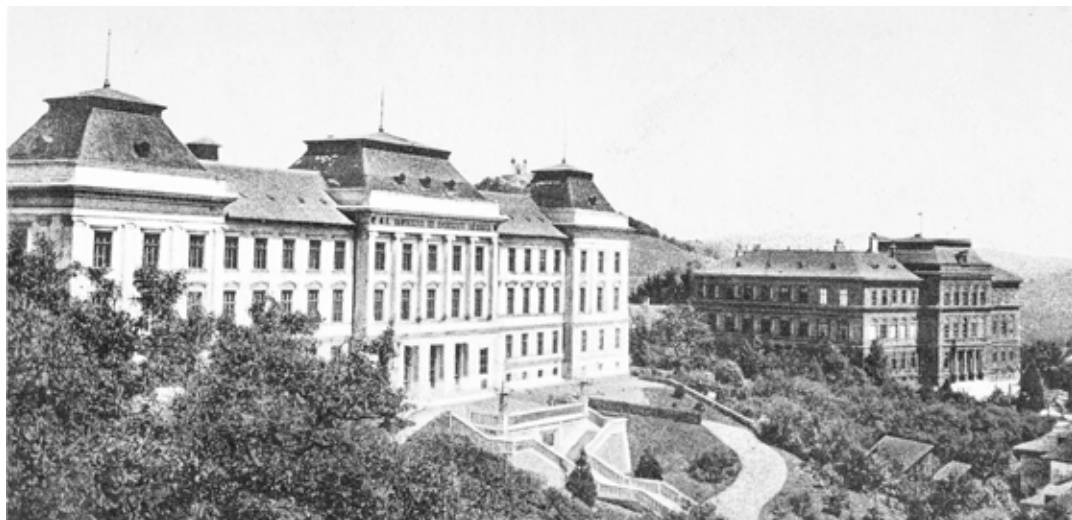
Historické budovy Baníckej a Lesníckej akadémie FOTO ARCHÍV ŠN
