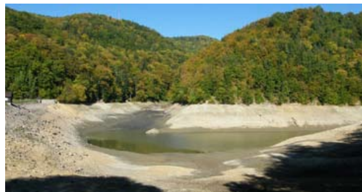
Vypustenie Dolnohoduškého tajchu pred rekonštrukciou
