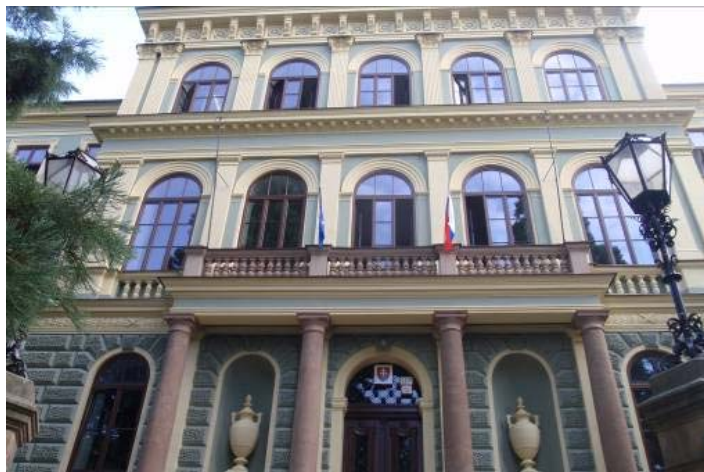
Pohľad na zrekonštruovanú čelnú fasádu školy. FOTO JANETTA HUDECOVÁ
