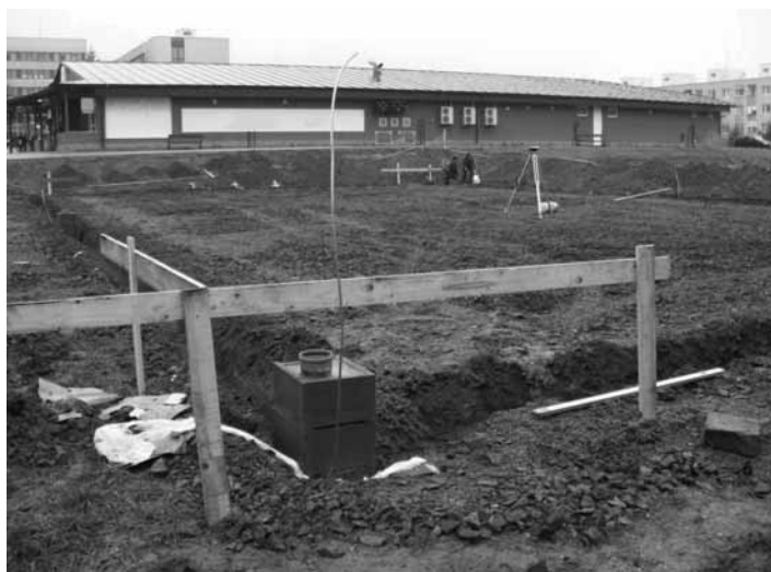
33.str. Stavebné práce na výstavbe multifunkčného ihriska FOTO M. RUŠČÁK
