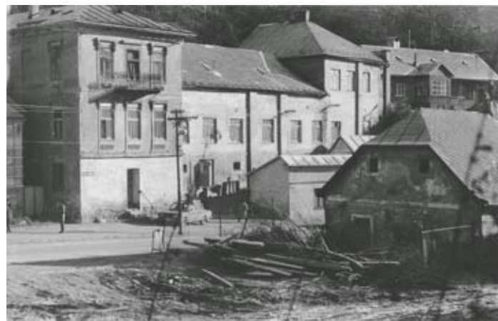
Budova "Šuster fabrika" FOTO ARCHÍV OEGY KUČTOVEJ
