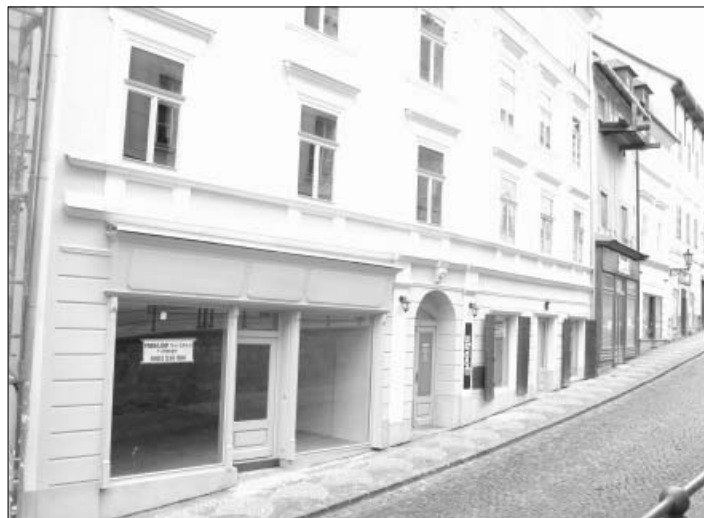
Vonkajšia fasáda Carl. Jungovho domu FOTO M. KRÍŽ
