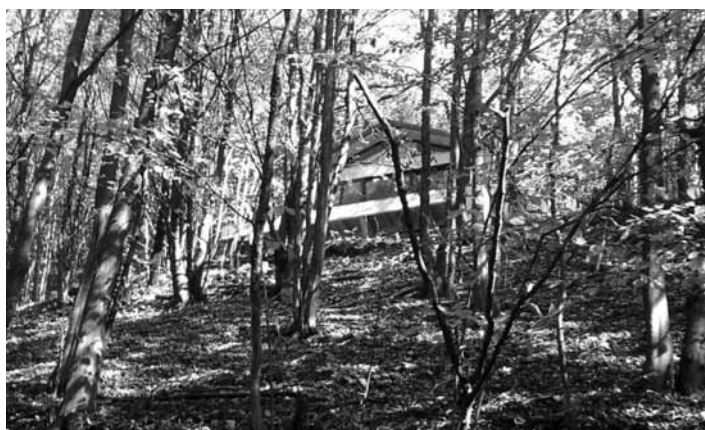
Nepovolená stavba – „Kotyď“ v BŠ FOTO MsÚ
