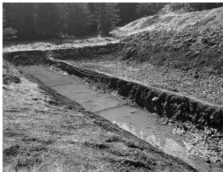
Sanačné práce na Antolskej ulici FOTO ARCHÍV AUTORA
