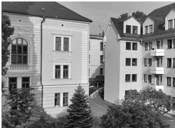
Budova školy a internát Písek FOTO KRISTÍNA GARAJOVÁ
