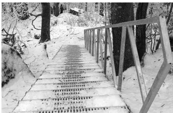
Nové ocelové schodisko FOTO ARCHÍV OOCR BS
