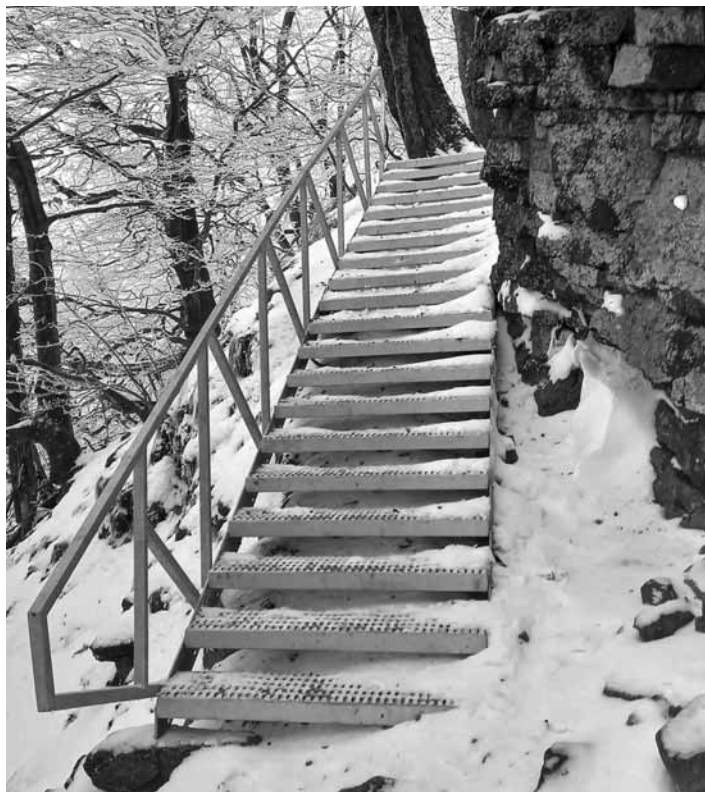
Kovové schody na Sitno FOTO ARCHÍV OOCR BS
