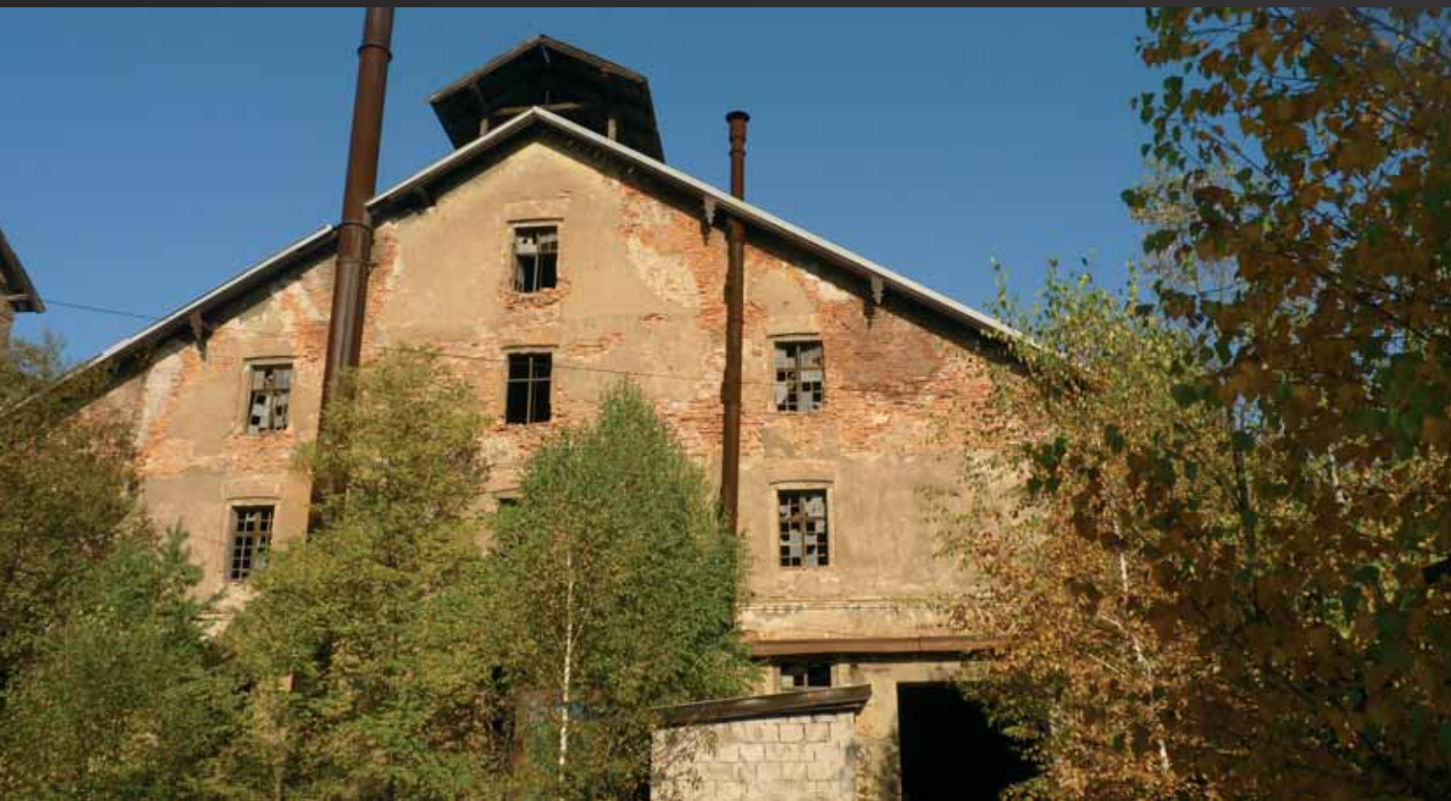
Banská Štiavnica, taviareň, hlavný objekt
