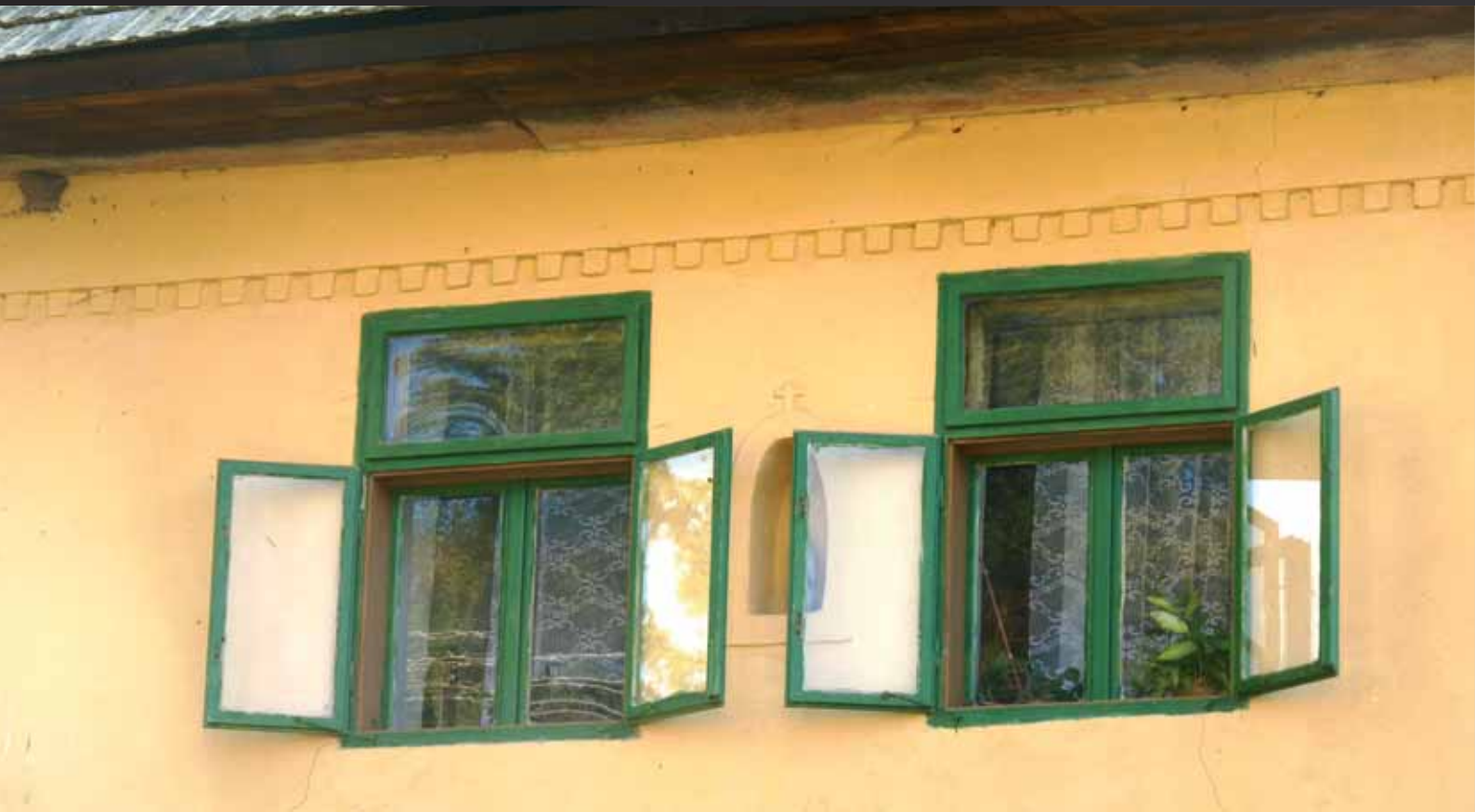
Banský Studenec, detail fasády ľudového domu
