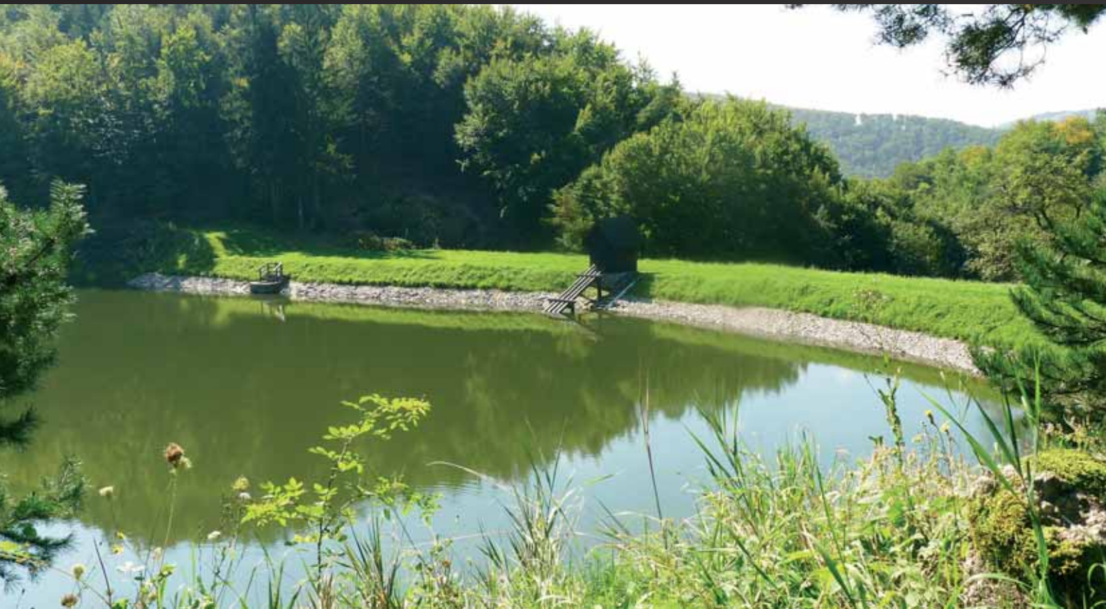
Hodruša – Hámre, časť Kopanice, miestna časť Baňa, vodná nádrž Moderštolňa
