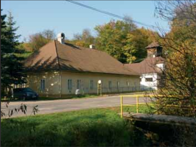
Svätý Anton, bývalá (banská ?) správna budova, v pozadí požiarna zbrojnica
