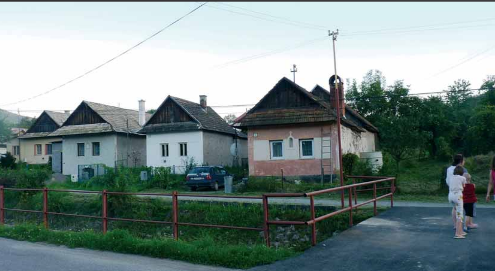
Voznica, integrálne zachovaná urbanistická štruktúra ľudových domov, s čiastočnou stratou pôvodnosti detailov ( najbližší dom má plastové okná bez členenia, úprava fasády 3. domu naľavo odstránila tradičné členenie),
