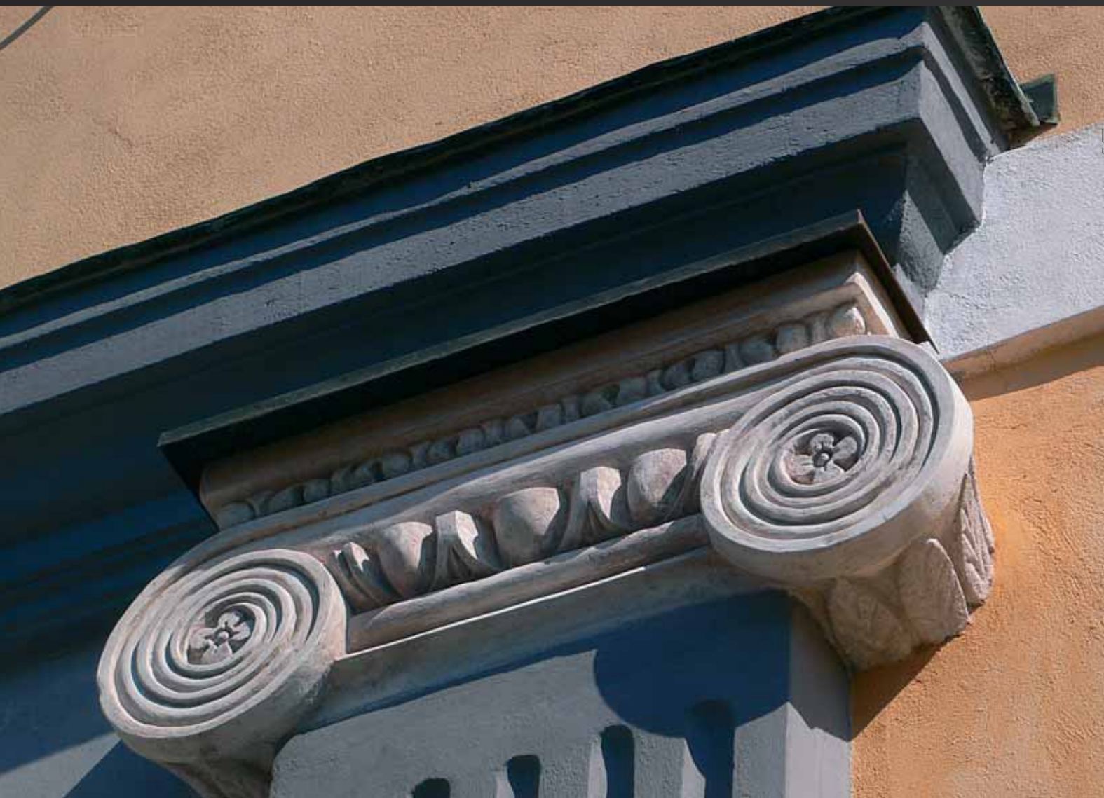
Banská Štiavnica, Dolná ružová ulica, detail portálu meštianskeho domu
