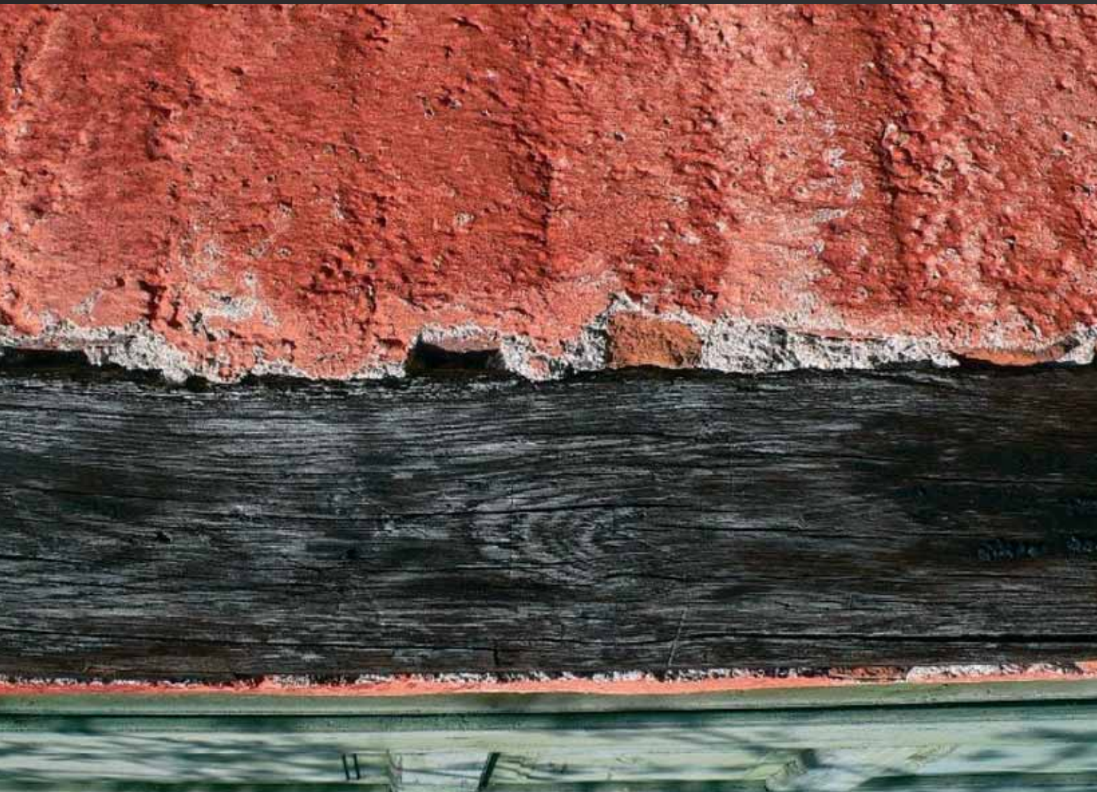
Svätý Anton, detail exteriérovej omietky ma hospodárskej budove
