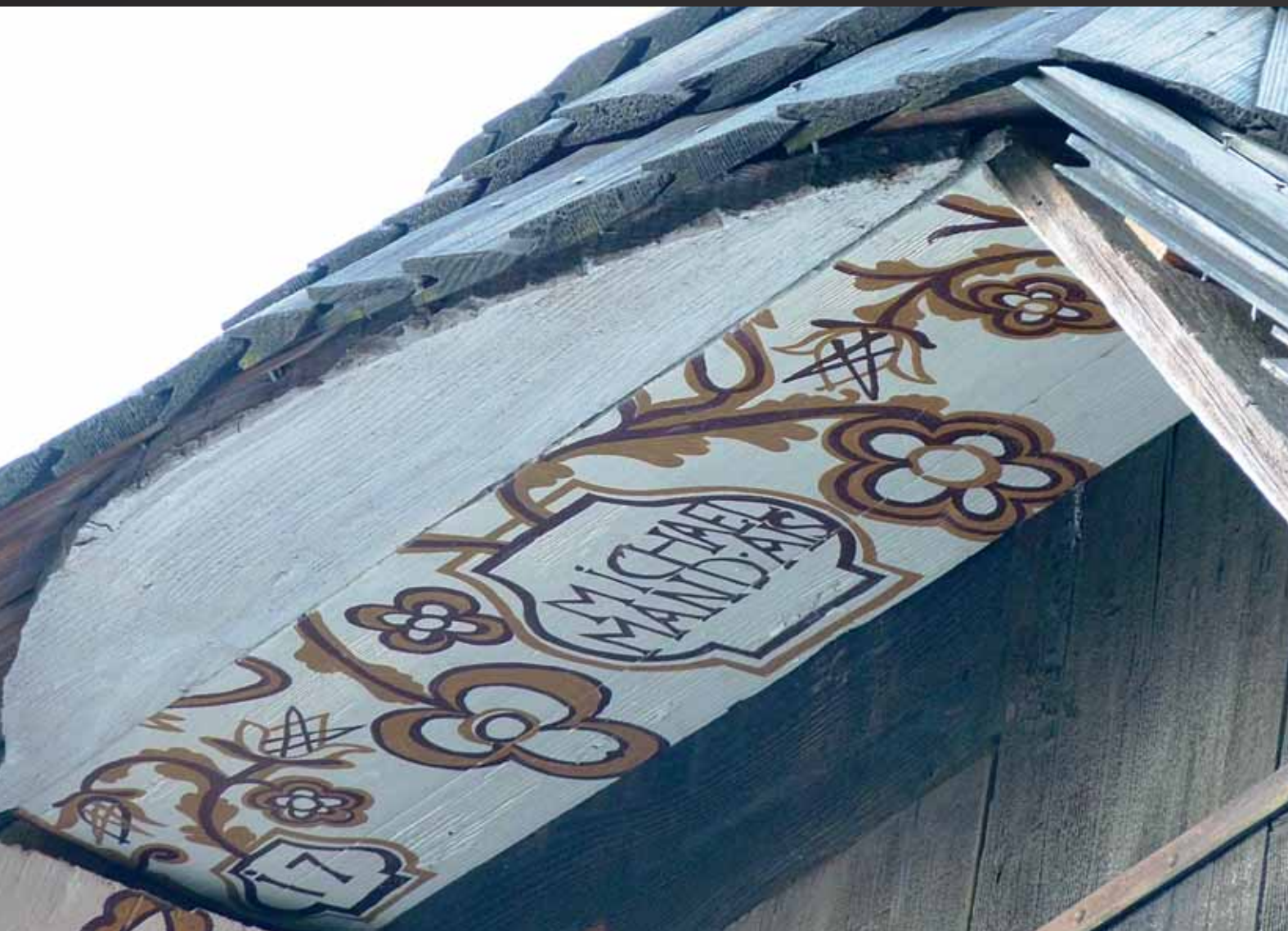
Banská Štiavnica, detail „kukly“ ľudového baníckeho domu, Horná ružová ulica
