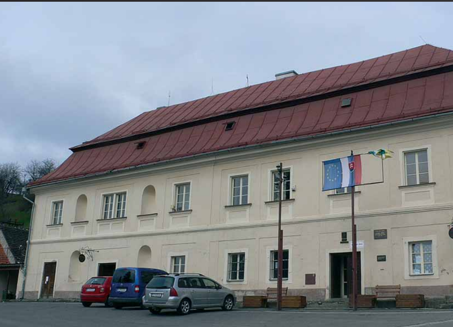
Štiavnické Bane, Banská správna budova
