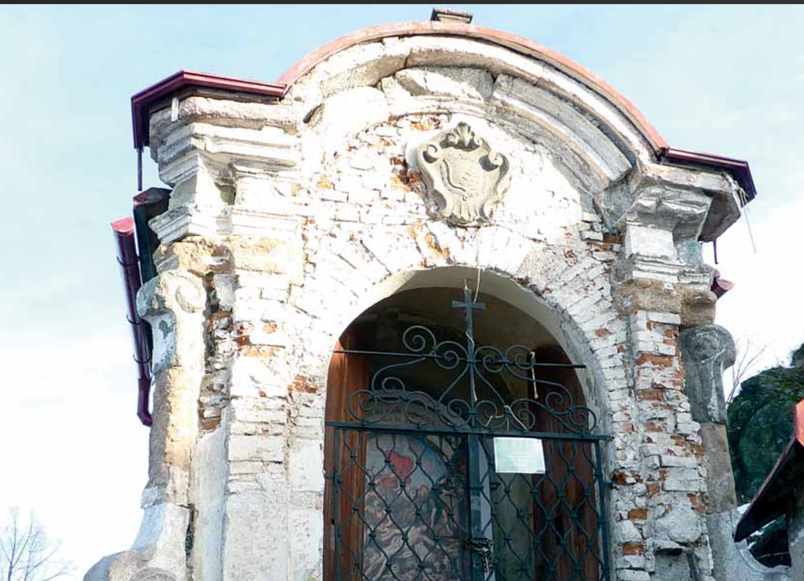
Kaplnka na Banskoštiavnickej kalvárii po odstránení cementových omietok, stav z roku 2010
