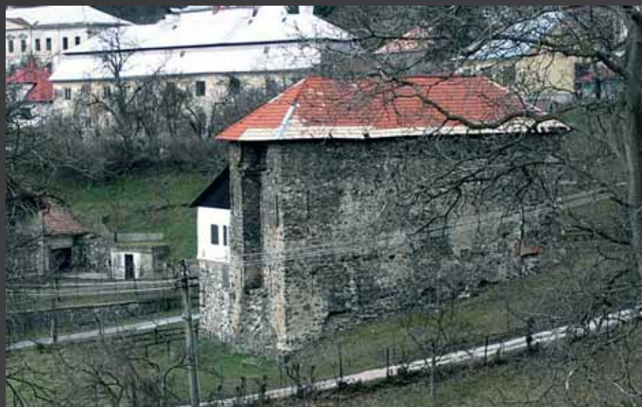
Štiavnické Bane, budova strojovne, v pozadí budova banského meračstva
