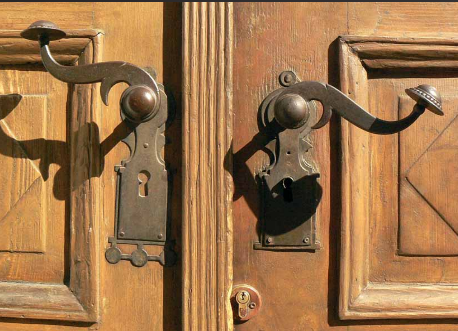
Banská Štiavnica, remeselne opravené vstupné dvere s kovaním
